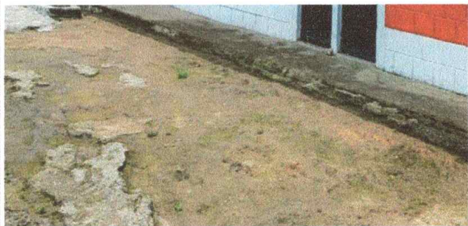
Foto 7. Reparacion de plancha de concreto en patio
