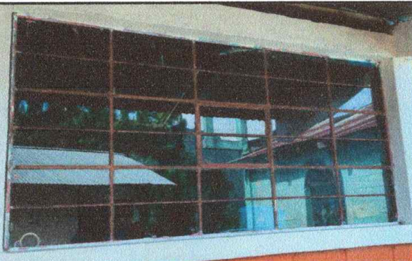
Foto 3. Sustrucion de estructura de metal de ventana en modulos aulas parte de enfrente
