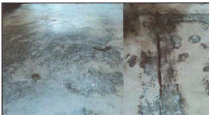
Foto 4. Sustrución de torta de cemento por piso cerámico, modulo aulas y dirección
