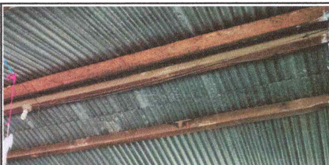
Foto 5. Reparación de sistema eléctrico
