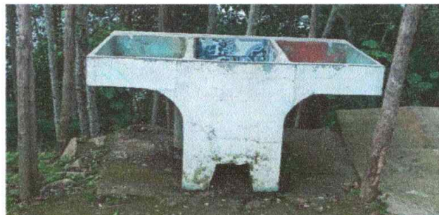
Foto 8. Sustitución de pila plástica de dos lavaderos
