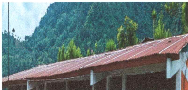
Foto 1. Sustrucion de lámina, por lámina troquelada. En aulas y dirección
